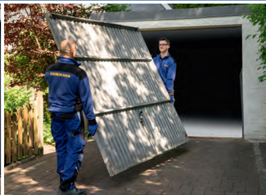
Ausbau und umweltgerechte Entsorgung
